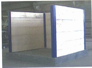
PLATFORMĂ INDIVIDUALĂ Platformă individuală corect construită, folosită pentru colectarea și depozitarea gunoii de grajd.
