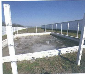
PLATFORMA COMUNALĂ Dejecțiile lichide sunt colectate în bazine special amenajate. Gunoiul menajer este depozitat în buncărele de reciclare.
